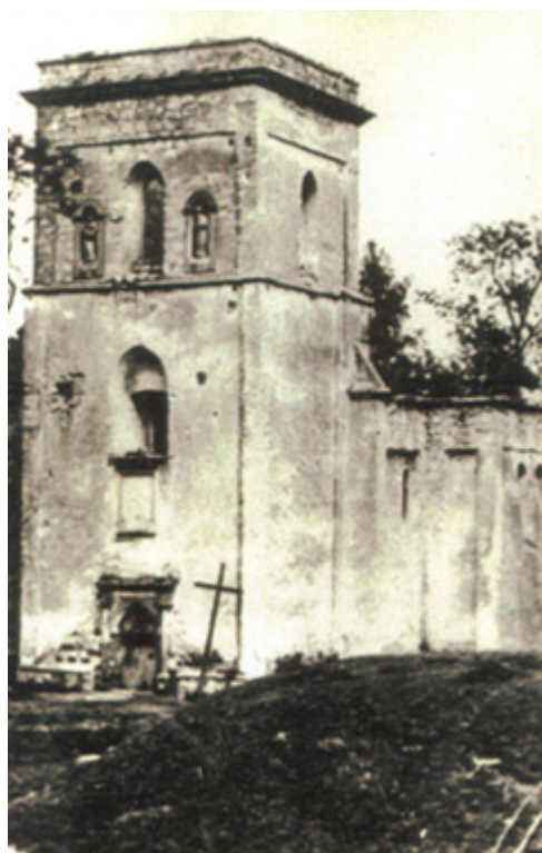
Spalony kościół buszczecki
