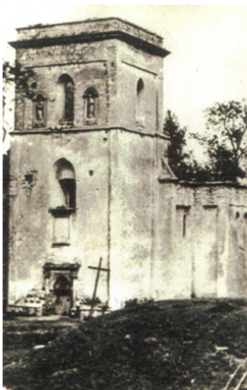
Spalony kościół buszczecki
